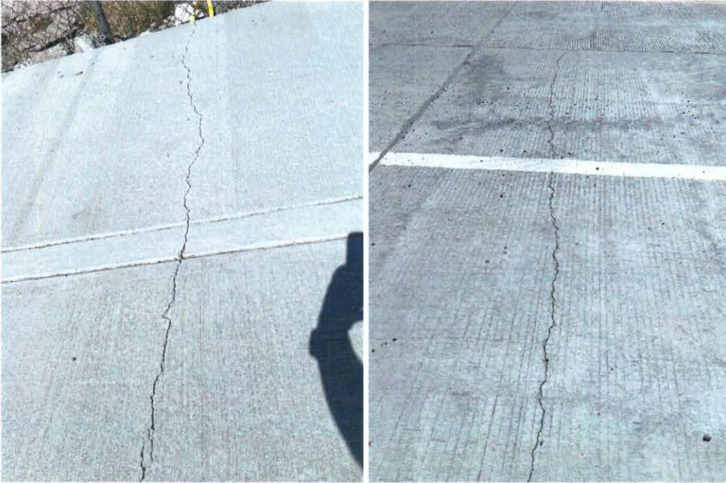
(Concretos de banquetas y pavimento fisurados)
